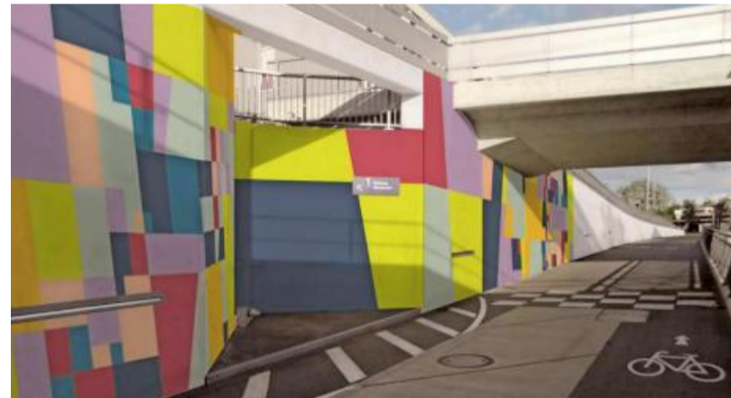
Der Entwurf von Leo Volland aus Berlin ist gekennzeichnet von einer vollflächig grafischen Bearbeitung der gesamten Wandfläche. Fotos: Hochbauamt
