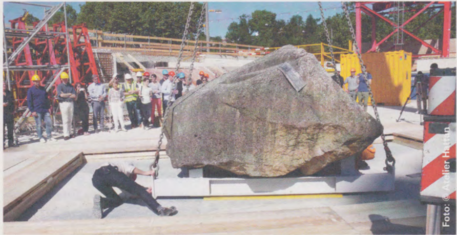
Eine «echte» Grundsteinlegung: Der Findling wird als Grundstein als erstes Element des Neubaus platziert.
