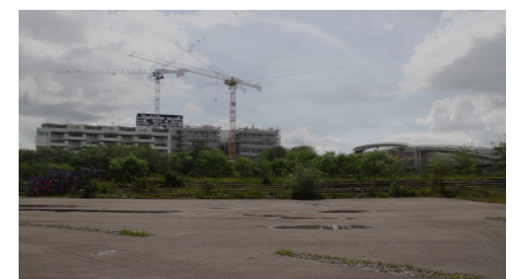
Trilogieansicht im Korridor EG, Alters- und Pflegezentrum Wägelwiesen Wallisellen
