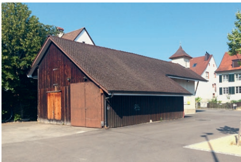
4.3 VORHER: So präsentierte sich der grosse, ungenutzte Schopf vor dem Umbau zur Platzseite
