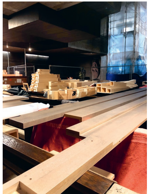
1.5 Die hölzernen Orgelpfeifen liegen für den Einbau bereit
