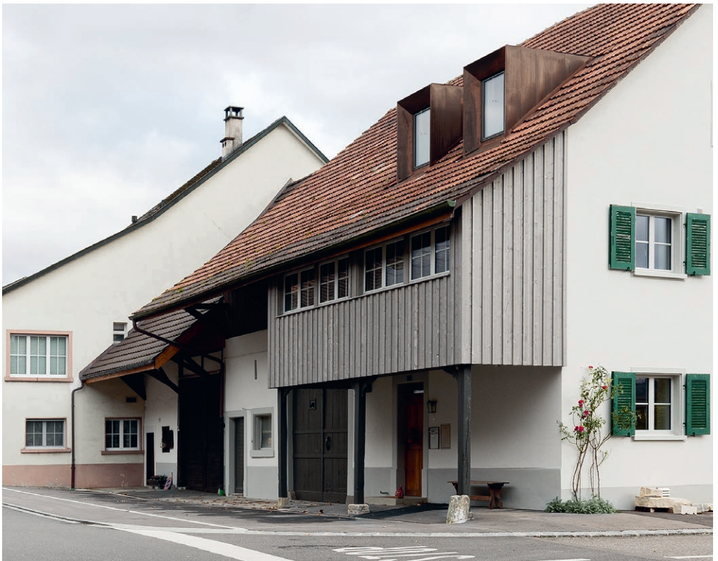
5.1 Die neuen Dachaufbauten an der Hauptstrasse in Seltisberg
