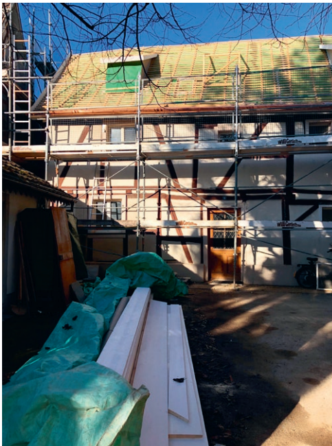
1.2 Neues Leben zieht ein: Die Liegenschaften an der Neuweilerstrasse in Allschwil
