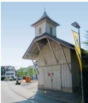
4.5 VORHER: Das ehemalige Feuerwehmagazin mit dem aufgesetzten Dachreiter, der zum Aufhängen und Trocknen der Feuerwehschläuche diente
