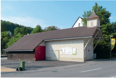
4.1 VORHER: Das alte Feuerwehmagazin wartet auf seine neue Nutzung
