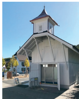
4.6 NACHHER: Die Tore stehen wieder offen. Die eindruckliche Holzarchitektur konnte erhalten und fachgerecht renoviert werden
