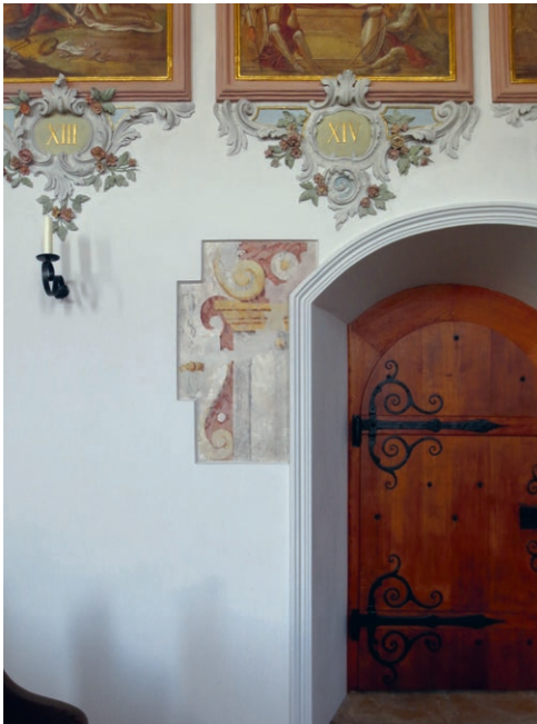
2.3 1962 freigelegtes Fragment der bauzeitlichen Dekoration an den Schiffswänden
