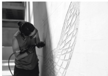
Abb./Fig. 6 Judith Albert, BASICS , ZHAW Winterthur, 2019/20. Die vorgezeichneten Linien werden von Steinbildhauern in den Beton gestockt. Judith Albert, BASICS , ZHAW Winterthur, 2019/20. The drawn lines are cut into the concrete by stone carvers.
